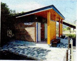
会津坂下駅前一新築された公衆トイレ
