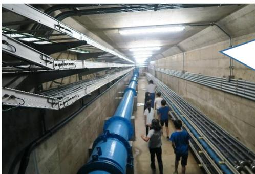
そして、熱塩浄水場です。日中ダムに貯められた水は、この浄水場まで管をつたって流れてきます。それを、水道水になるまで、薬品を入れ、ろ過をしてきれいにします
