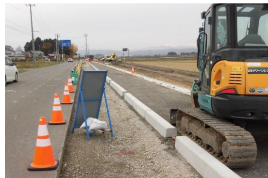
↑ えん長工事が進む歩道
