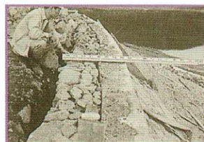
昭和42年の改修工事
